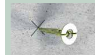
1. Positioneren, voorboren niet nodig
